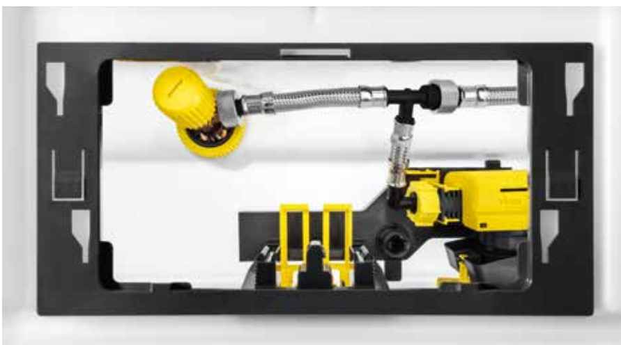
Dusch-WC-Anschluss in Sekunden: Der Anschlussadapter macht's möglich.
