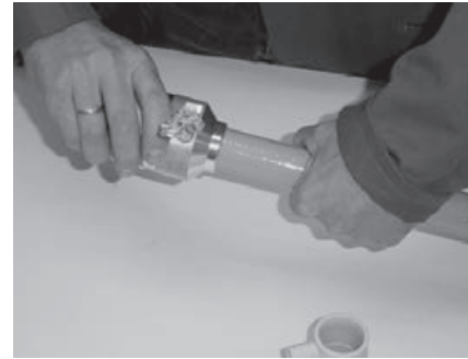
3. Bei Bänninger Stabi-Verbund-Rohr muss vor der Verbindung der Aluminiummantel abgeschält werden.
