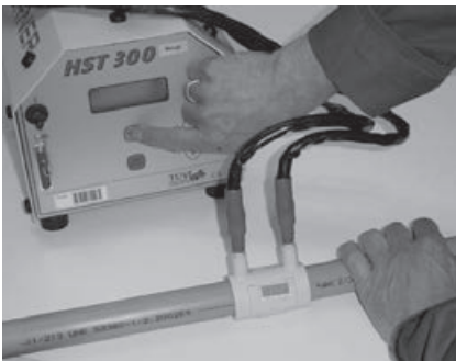
7. Die Kabelstecker in die Kontakt- buchse stecken. Voltzahl und Schweißzeit in Schweißgerät eingeben. Schweiß- daten sind auf dem Barcode-Auf- kleber auf der Muffe zu ersehen. Schweißgerät mittels Schalter star- ten.
