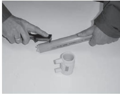
2. Äußere Oxydschicht mittels Zieh- klinge entfernen.
