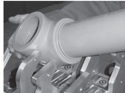
Abb. 12 Schweißverbindung nach Ende der Abkühlzeit aus den Klemmbacken entnehmen
