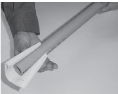
4. Fügeflächen mit Reiniger säubern.
