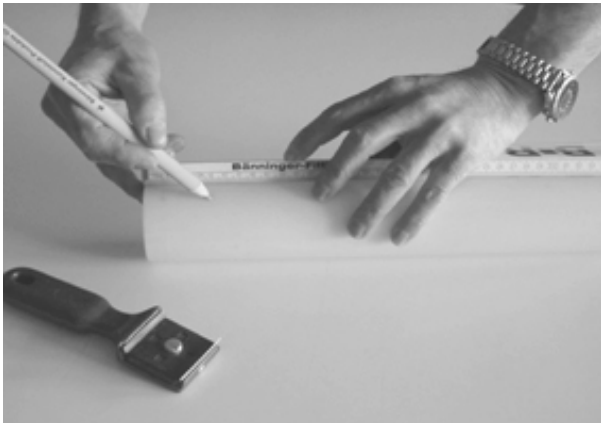
Muffeneinstecktiefe anzeichnen
