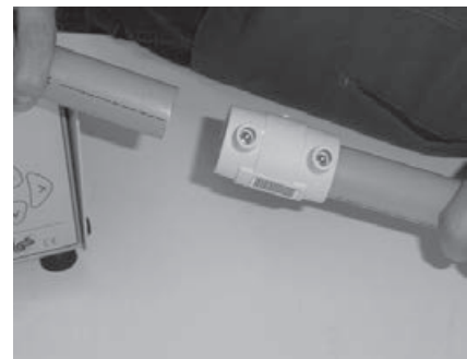
6. Muffe bis zur markierten Stelle auf das Rohr schieben.
